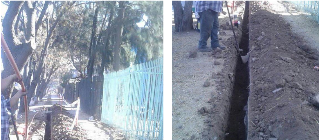
Foto 15 y 16. Zanjado Primera Etapa Obra de Confianza
